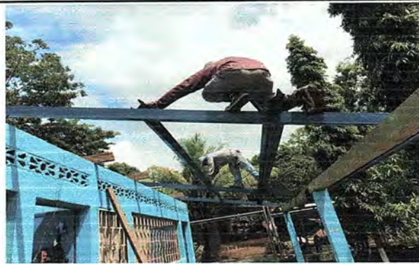
Foto 2: Cambio de techo de madera por techo de metal en corredor de módulo 1.
