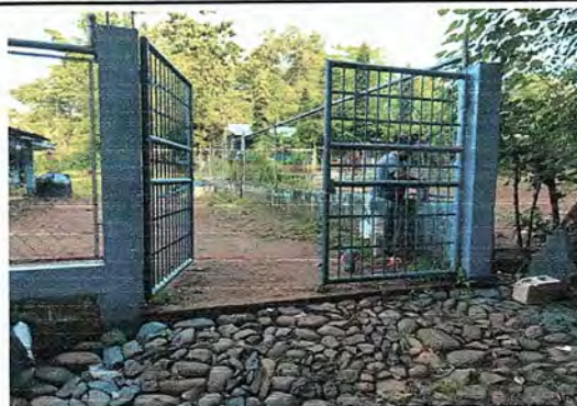
Foto 4: Pintura a muro exterior de acceso al centro educativo.
