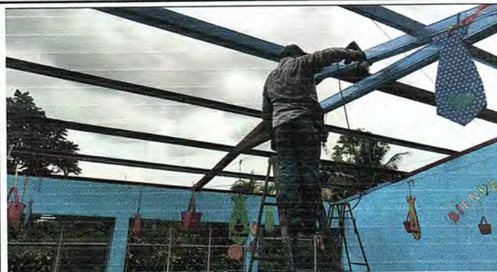
Foto 1: Cambio de lámina por lámina troquelada, mantenimiento a estructura de metal existente y reforzamiento con cuatro costaneras más en aula 1 del módulo 2.
