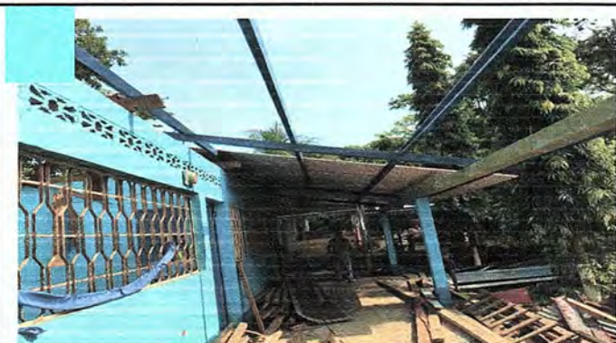
Foto 3: Cambio de techo de madera por techo de metal en corredor de módulo 1.
