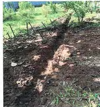
Foto 2: Instalación de tubería principal de pozo a cisterna.
