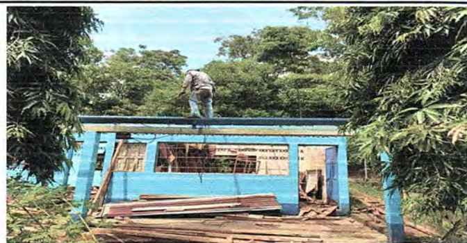
Foto 5: Cambio de lámina existente por lámina troquelada calibre 26 en módulo 1.
