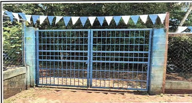
Foto 6: Reparación y reforzamiento de portón de entrada al establecimiento. Falta pintura en los muros de soporte.
