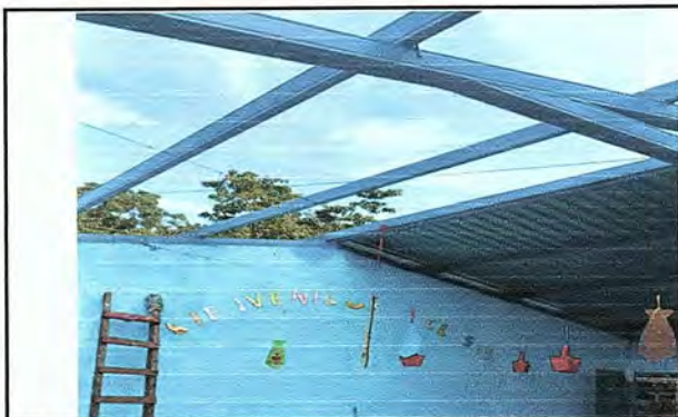
Foto 5: Aula 2 del módulo 2. Cambio de lámina por lámina troquelada, mantenimiento a estructura de metal existente y reforzamiento con cuatro costaneras más.
