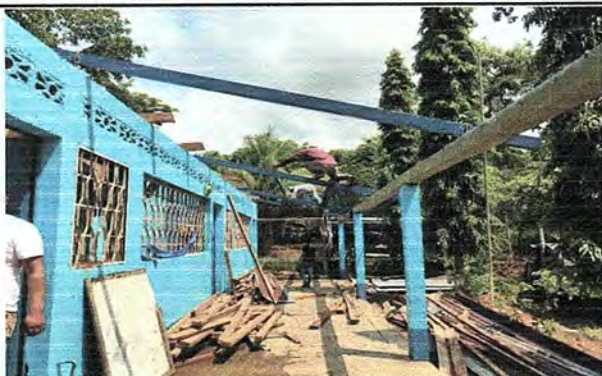
Foto 1: Cambio de techo de madera por techo de metal en corredor de módulo 1.
