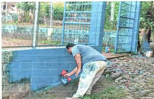
Foto 5: Recubrimiento con pintura de aceite a muro perimetral parte frontal que da hacia la calle principal.
