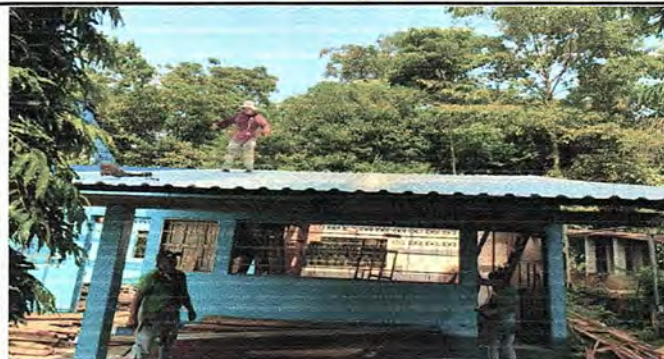
Foto 6: Instalación de lámina troquelada calibre 26 en módulo 1. (aulas y corredor)
