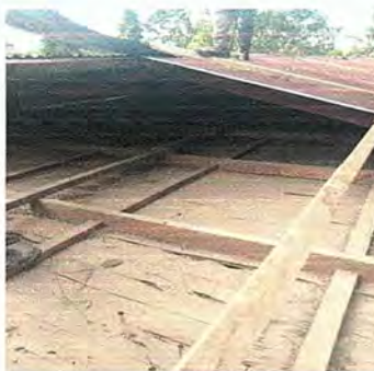
Foto 4: Desinstalación de estructura portante de madera en el módulo 1 (aulas y corredor)
