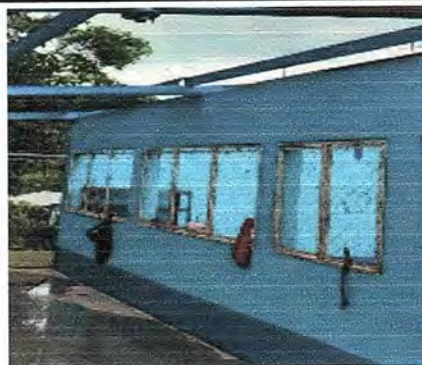
Foto 4: Mantenimiento y reforzamiento de balcones del módulo 2.
