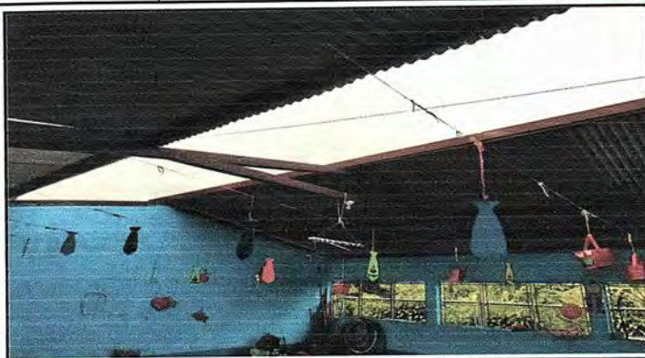
Foto 2: Cambio de lámina por lámina troquelada, mantenimiento a estructura de metal existente y reforzamiento con cuatro costaneras más en aula 2 del módulo 2.
