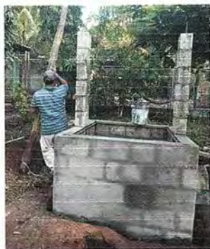
Foto 3: Elaboración de techo e instalación de cableado eléctrico para bomba de agua.
