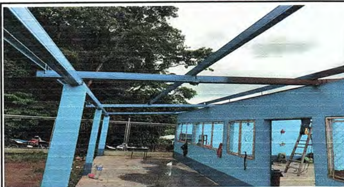
Foto 3: Corredor del módulo 2 en el cual se hicieron los mismos trabajos y modificaciones.
