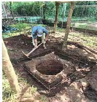
Foto1: Elaboración de brocal para pozo .
